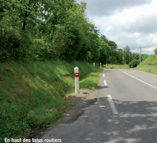
En haut des talus routiers
